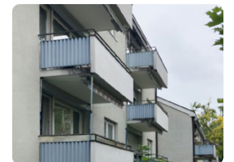
Alle Balkone erhalten neue Rollläden und Sonnenstoren.
