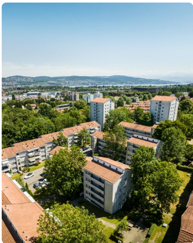
Der südliche Teil der Siedlung mit den beiden markanten Hochhäusern.
