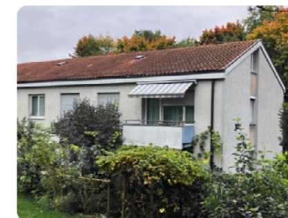
Die Dachböden werden gedämmt, eine Photovoltaik-Anlage wird installiert.
