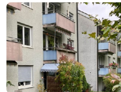
Ein neues Farbkonzept wird die Fassaden auffrischen.
