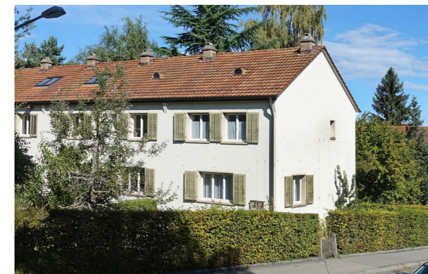
Reiheneinfamilienhaus der bestehenden Siedlung
