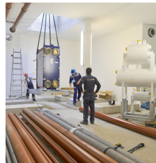
Bau der 1. Energiezentrale (2014)
